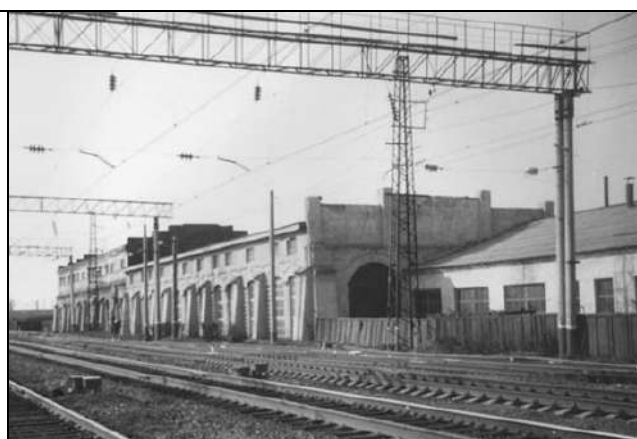
Рис. 5. Здание паровозного депо
